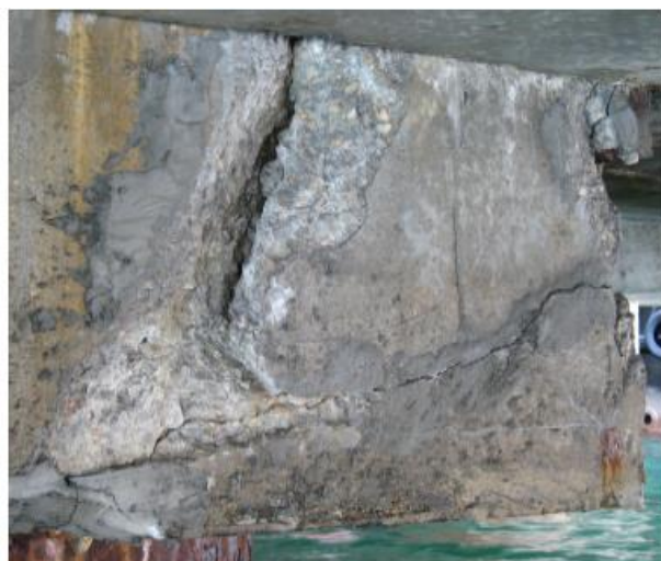
Рис. 3.1. Свая № 13Б. Трещины раскрытием до 5 мм с потерей монолитности бетона капители и сколы глубиной до 50 мм
