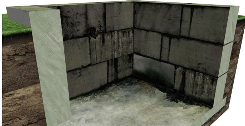
Рисунок 1. Протечки через межблочные швы
